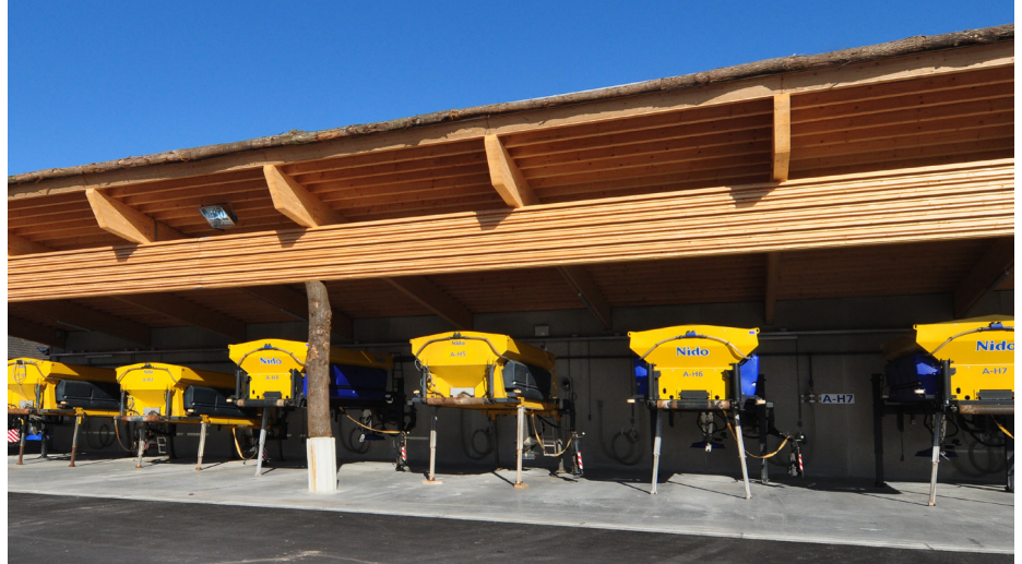
stalling met iedere 16 meter een boomstam kolom
