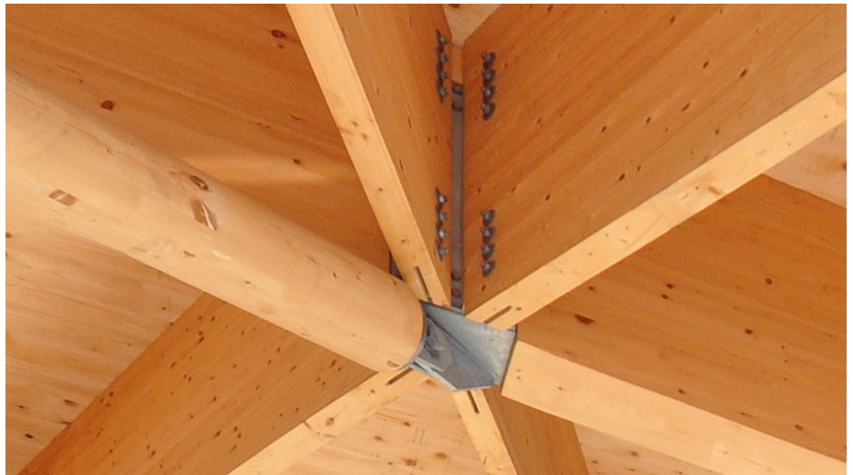
houten dakconstructie zoutloods
