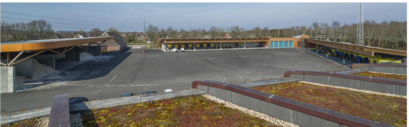
terrein van het wegensteunpunt met kantoren, zoutloods, stallen en kantine
