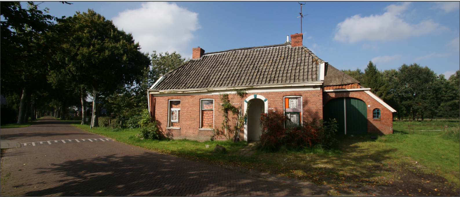
Gevelaanzicht vanaf de straat voor de verbouwing
