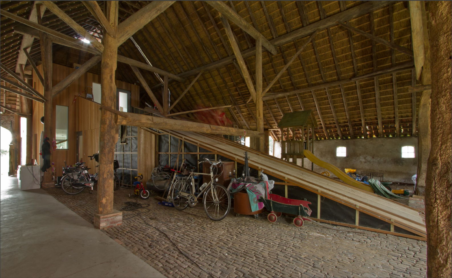
Binnen in de schuur vlak na oplevering, de opdrachtgever timmerde het deel op de foto zelf verder af.
