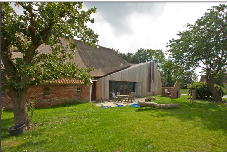
Overgang tussen oude schuur en nieuwe woning
