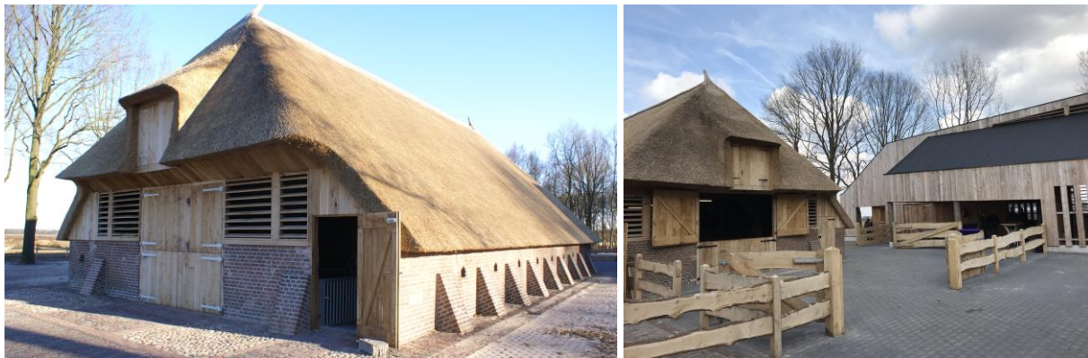
Afbeelding 3&4. De gerestaureerde schaapskooi, de lamellen in de gevel zorgen voor een betere ventilatie.
