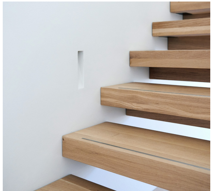
Detail eiken traptreden met rvs slijstrips en inbouwarmaturen in de wand
