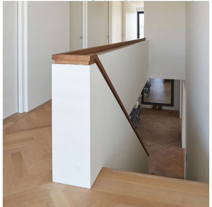
Detailering trapleuning, plintloze vloeren en traptrede
