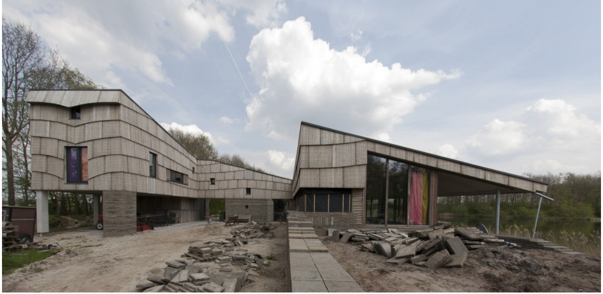
Het woonhuis wordt bewoont, het stapelen van de betontegels is begonnen. 2013.
