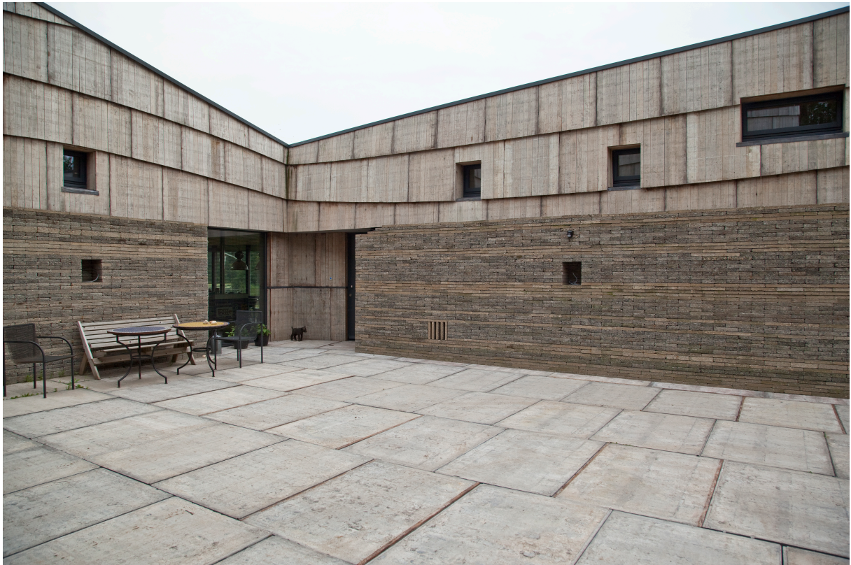
Het stapelen is gereed. Einde 2016. Betontegels, steenschotten van hout als gevel en steenschotten van kunststof als bestrating.
