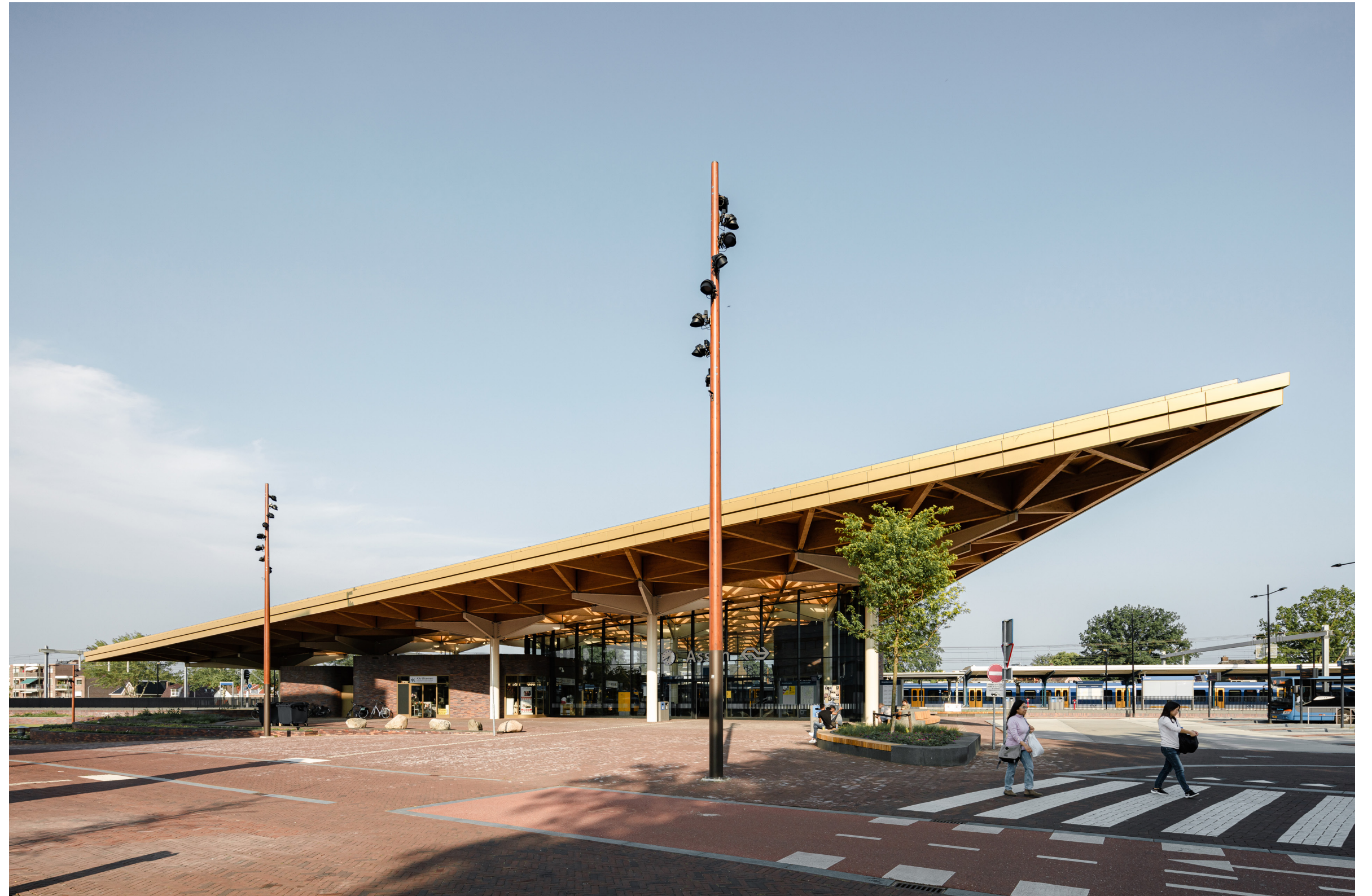
Het station is vanaf alle kanten transparant en uitnodigend
