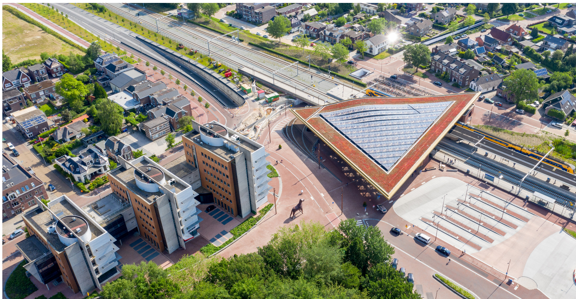
Drentse Architectuurprijs - Station Assen
