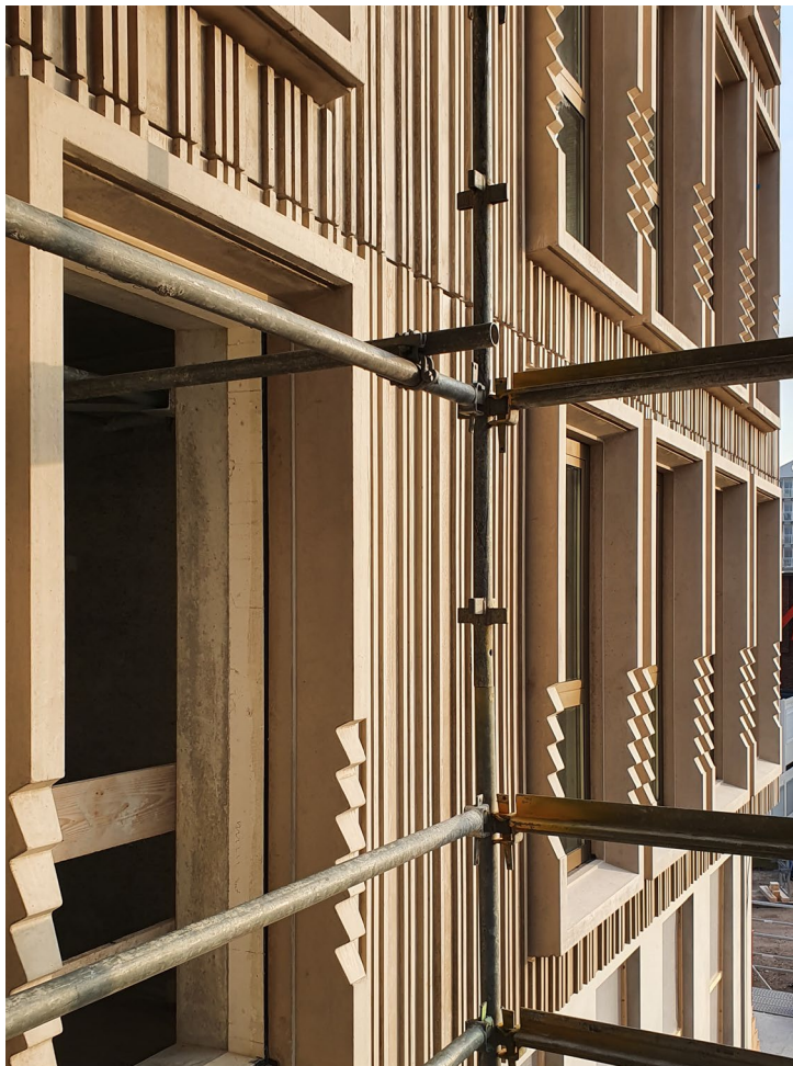
In Coevorden gemaakte prefab betonelementen zijn decoratief en rijk in detail.
