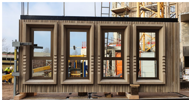
Geïsoleerd prefab element, lucht- en waterdicht, klaar om te monteren
