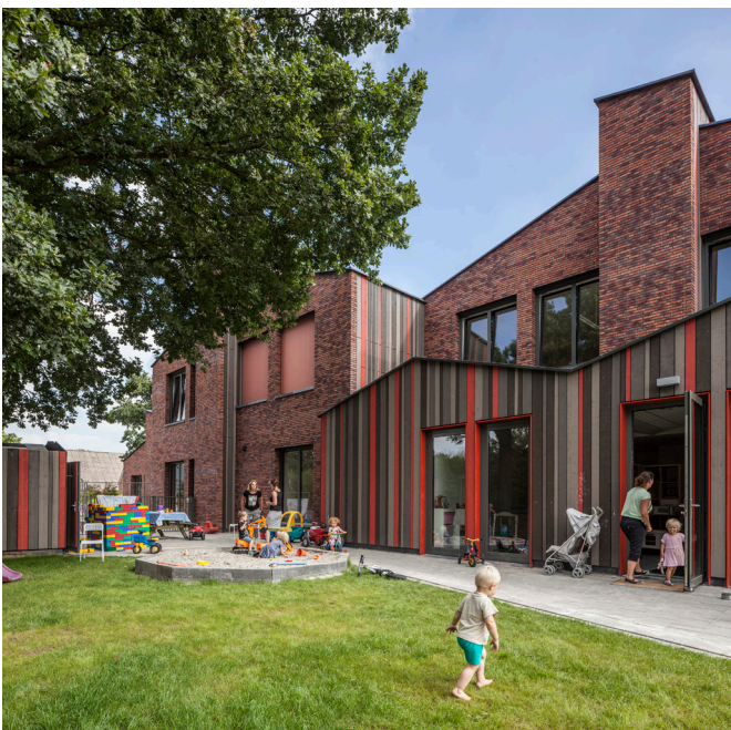
In de schoorstenen zijn ventilatiesystemen ondergebracht zodat in elk klaslokaal individueel de frisse lucht kan worden geregeld
