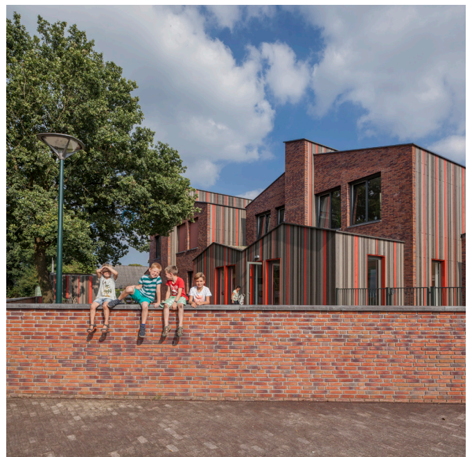
In de schoorstenen zijn ventilatiesystemen ondergebracht zodat in elk klaslokaal individueel de frisse lucht kan worden geregeld
